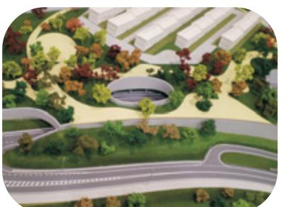
Además de las **pantallas acústicas**, el cubrimiento a realizar para el **soterramiento** de la **A-8** entre los barrios de Bentazarra y Lezeaga y el que se ejecutará en la zona de **Santa Ana** (con material absorbente en paredes y techo), así como el túnel excavado consiguen una gran **minimización** de los efectos de la **contaminación acústica**.
